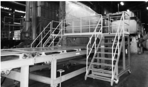
보행자용 출입구 설치
