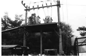
배선용 전주 설치
